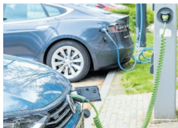
Punto de recarga de vehículos eléctricos. AEDIVE
