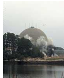
Demolición de la contención de la central nuclear de Maine Yankee.
