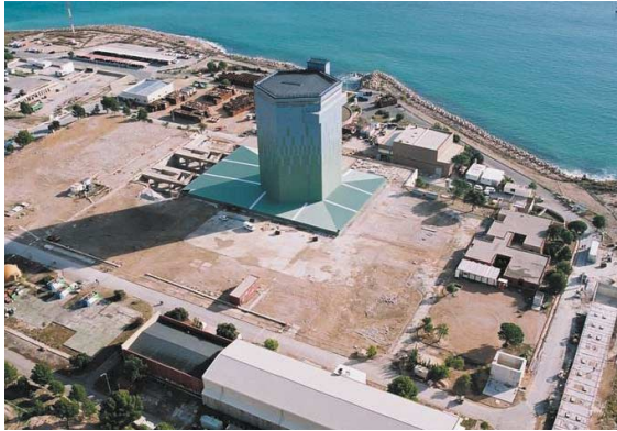
Estado actual del desmantelamiento de la central nuclear Vandellós I.
