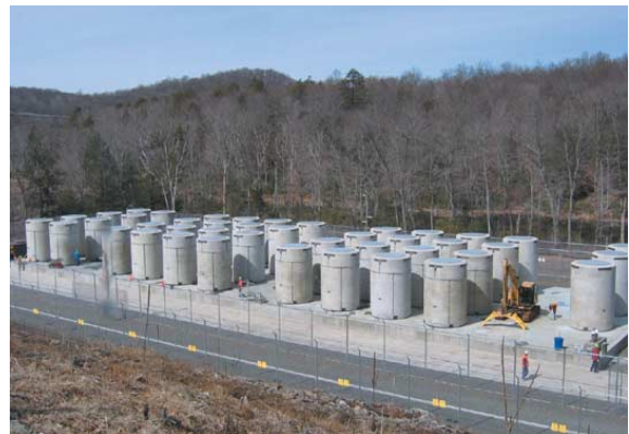
Almacenamiento temporal de elementos combustibles en contenedores de hormigón y acero.
