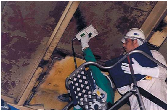
Comprobación del nivel de descontaminación alcanzado, antes de proceder a liberar o desclasificar estructuras y edificios.
