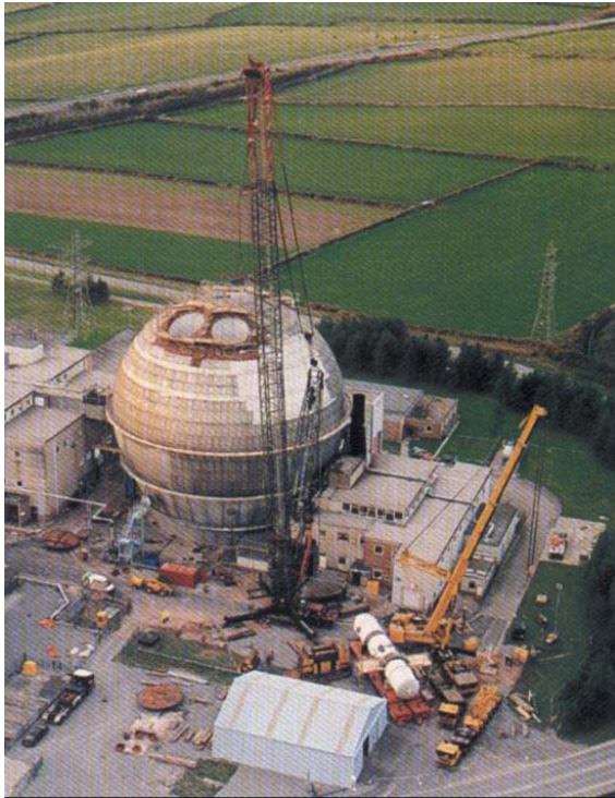
Desmantelamiento del reactor WAGR (Windscales Advances Gas-cooled Reactor), uno de los proyectos piloto del programa de investigación y desarrollo de la Comisión Europea para el desmantelamiento y clausura de instalaciones nucleares.
