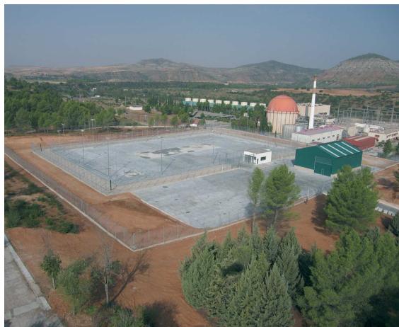
Almacenamiento temporal individualizado de los elementos combustibles en el emplazamiento de la central nuclear José Cabrera.
