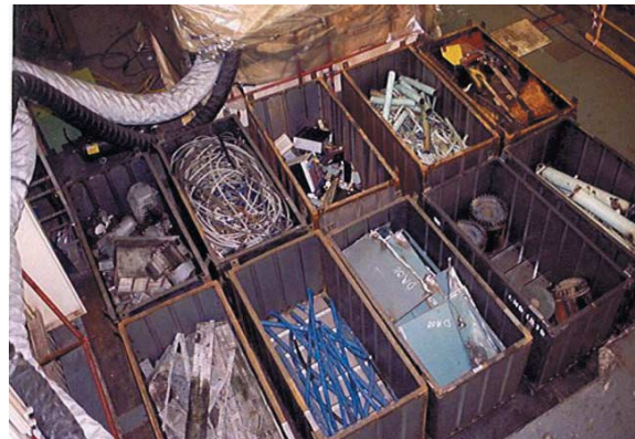
Segregación y acopio de materiales residuales durante el desmantelamiento de instalaciones nucleares.
