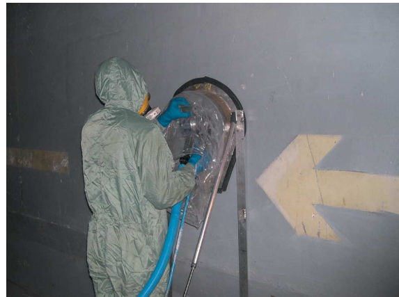
Escarificado y toma de muestras para el programa de caracterización de la instalación.
