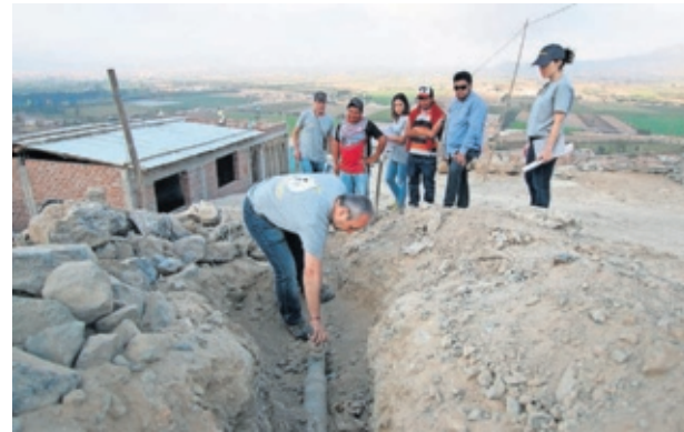
Sistema de abastecimiento de agua en Huaral (Perú).
