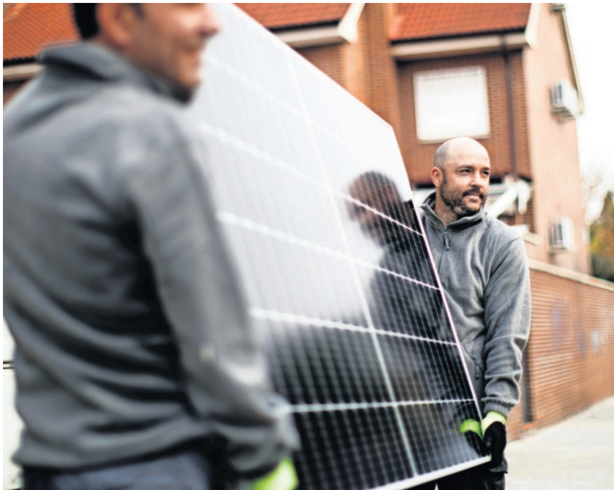
Dos técnicos instalan un panel fotovoltaico. GETTY
