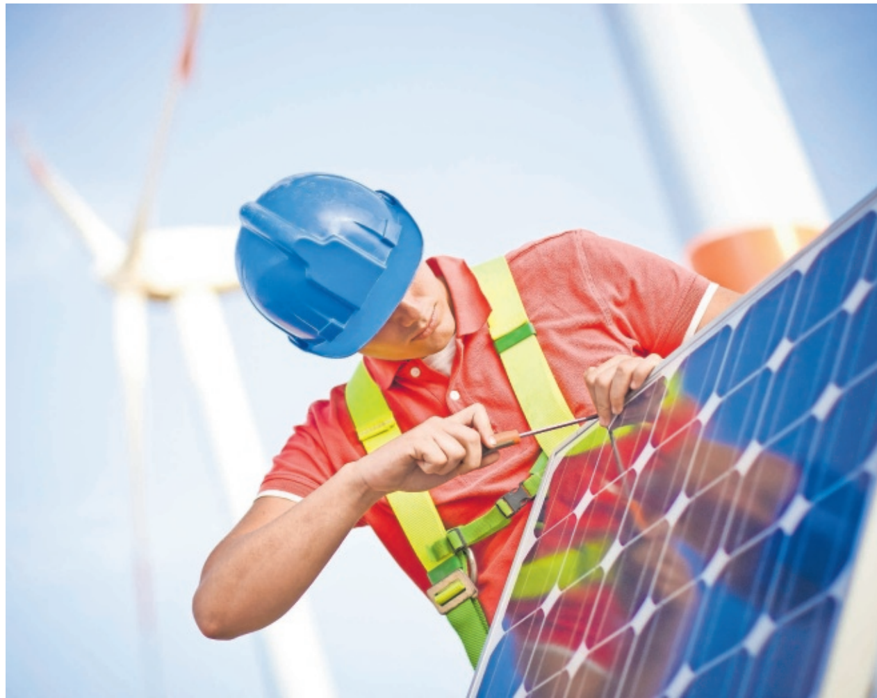
Un técnico instala un módulo solar fotovoltaico. GETTY IMAGES
