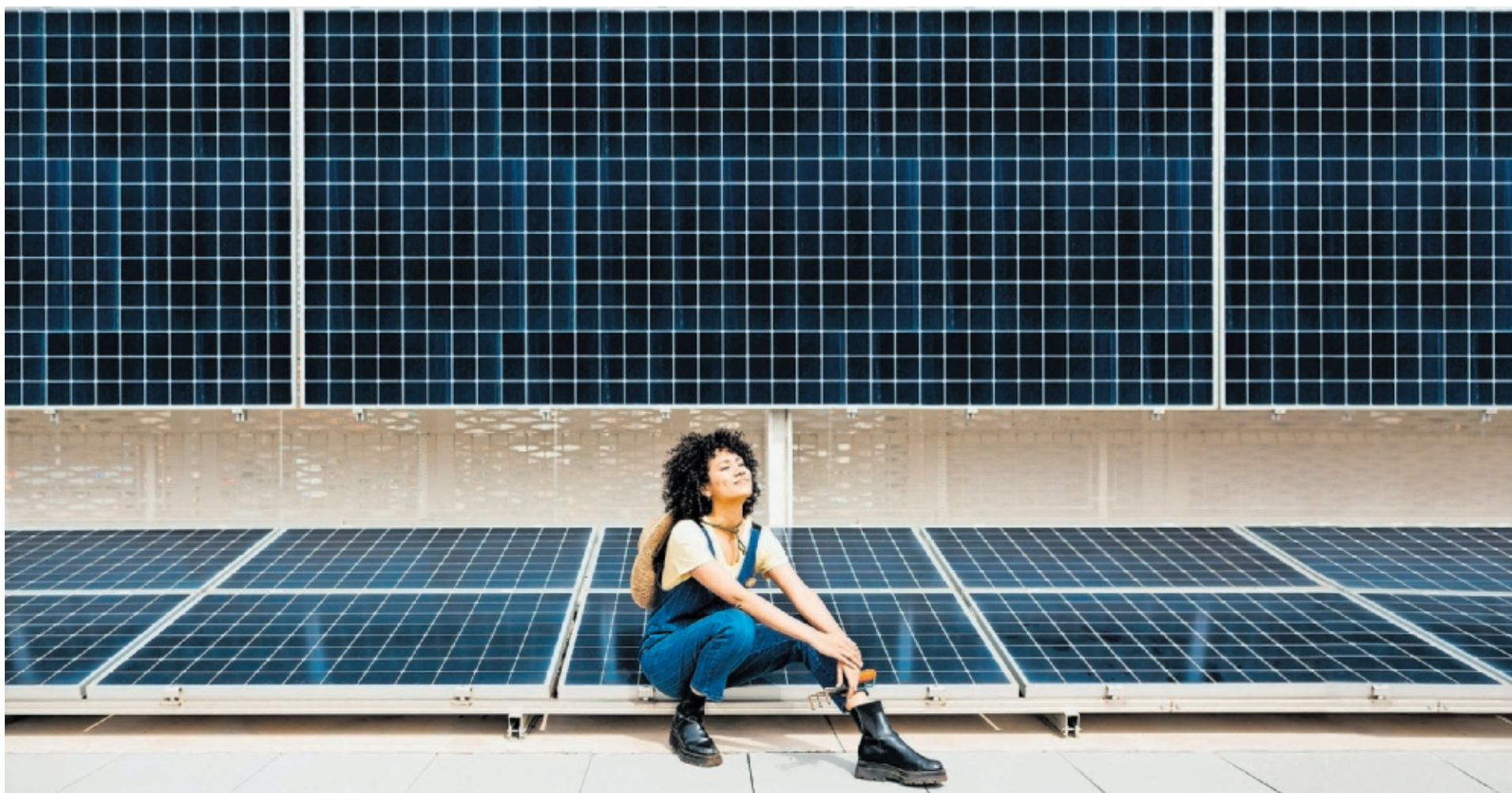
Paneles solares de autoconsumo.
