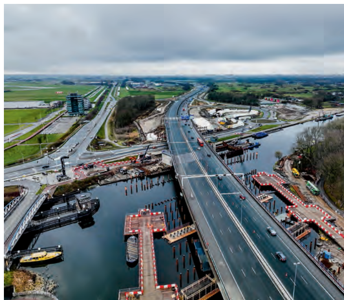
Ampliación de la autovía A-9 en Países Bajos.
