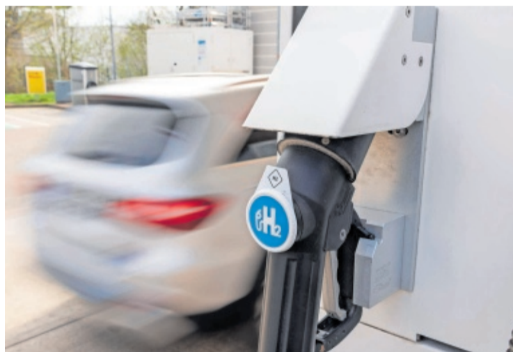
Estación de repostaje con tecnología de Bosch. Arriba, hidroducto de Bizkaia Energía.
