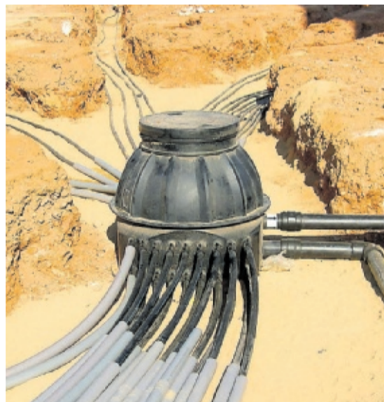
Arriba, instalación geotérmica en el polígono industrial A Granxa en Porriño (Pontevedra). A la izquierda, arqueta de unión de perforaciones Muovitech. Abajo, instalación de 24 sondeos geotérmicos para el edificio central de A Granxa.
