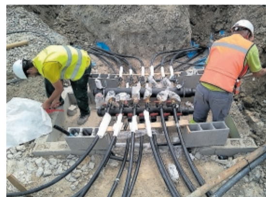
Arriba, instalación geotérmica en el polígono industrial A Granxa en Porriño (Pontevedra). A la izquierda, arqueta de unión de perforaciones Muovitech. Abajo, instalación de 24 sondeos geotérmicos para el edificio central de A Granxa.
