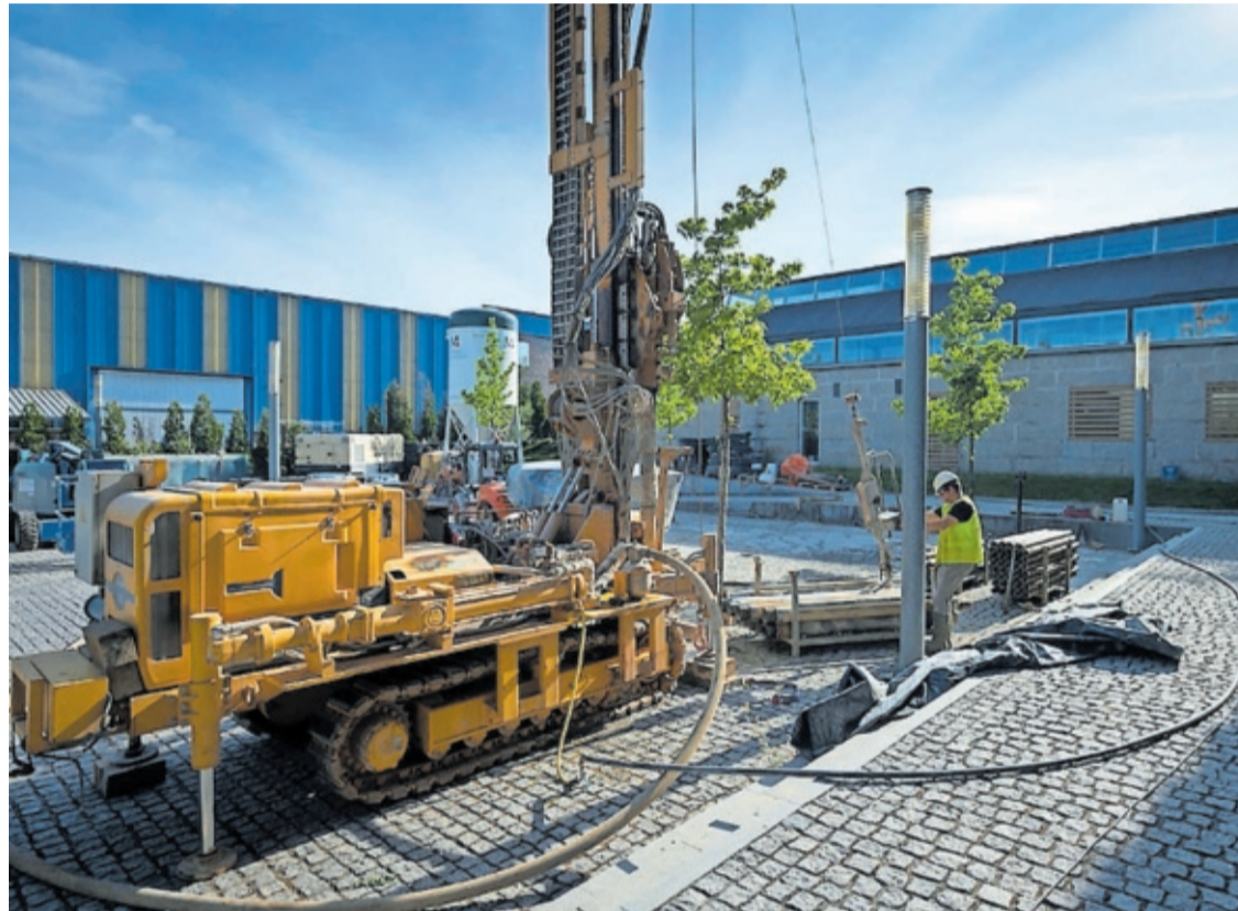
Arriba, instalación geotérmica en el polígono industrial A Granxa en Porriño (Pontevedra). A la izquierda, arqueta de unión de perforaciones Muovitech. Abajo, instalación de 24 sondeos geotérmicos para el edificio central de A Granxa.
