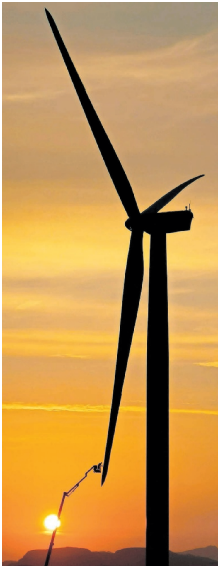
Un operario realiza trabajos de mantenimiento en un aerogenerador.
